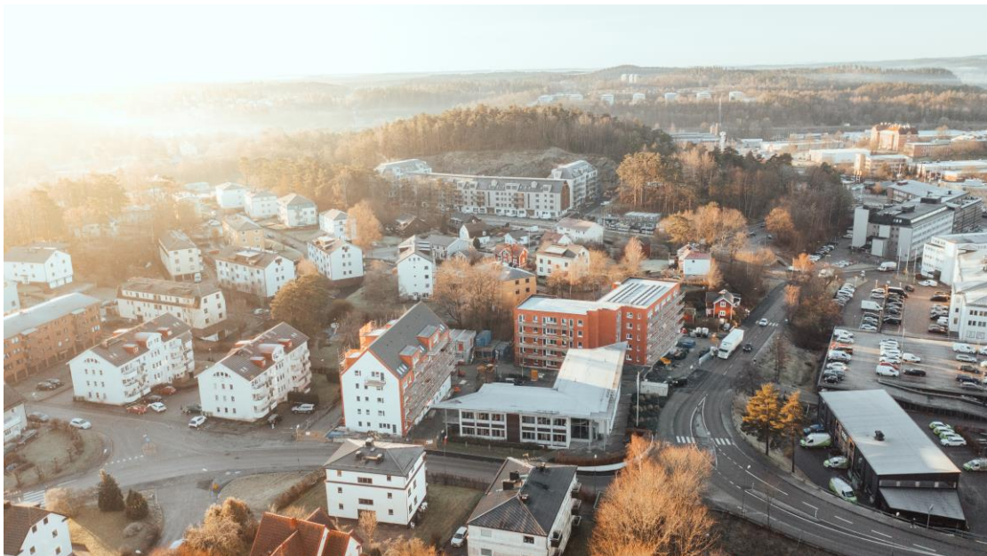
Bilden föreställer fastigheten Borås Hästhoven 2 under uppförandet i november 2021.
